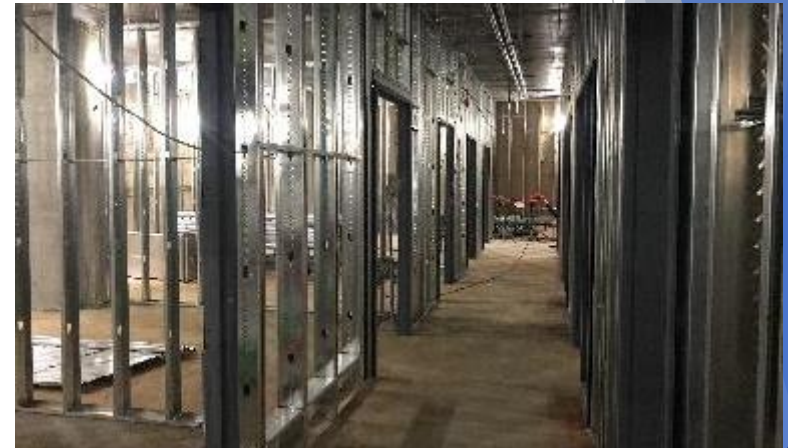
Basement Shell Framing & Door Frames
